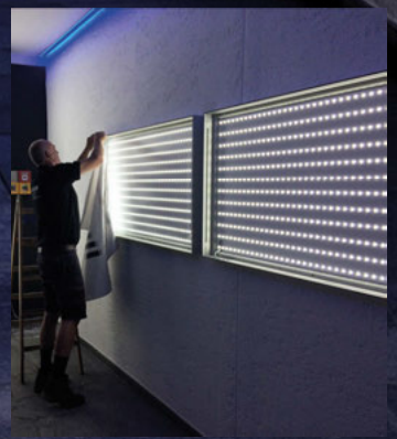
Die im Digitaldruckverfahren bedruckten Displaystoffe werden mittels Flachkeder in den Aluminiumrahmen gedrückt.
